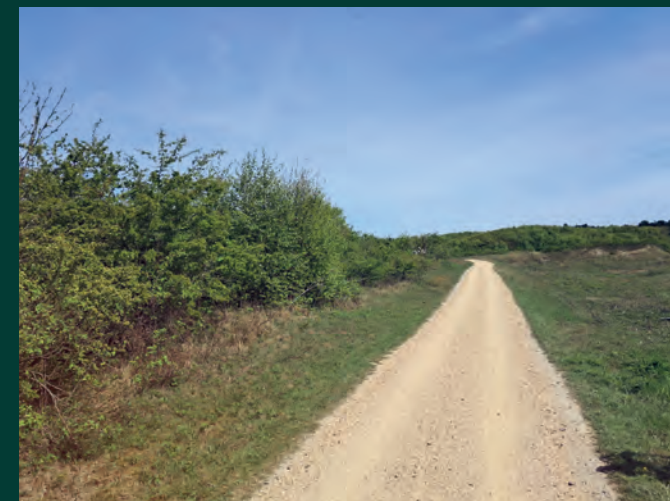
Afbeelding 8 Kleischelpenpad overlaagd met schelpen met leem
