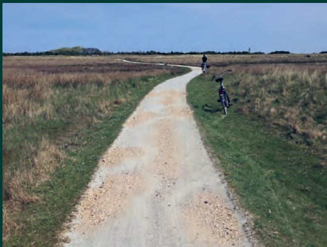
Afbeelding 12 Aanvulling van kuilen die ontstaan zijn door wateroverlast op het Kwelderpad
