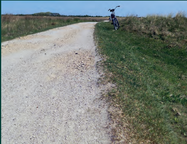
Afbeelding 4 Oplappende randen en kleurverschil in aanvulling
