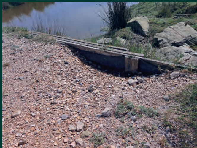
Afbeelding 6 Kuil bij de beschoeiing van de duiker
