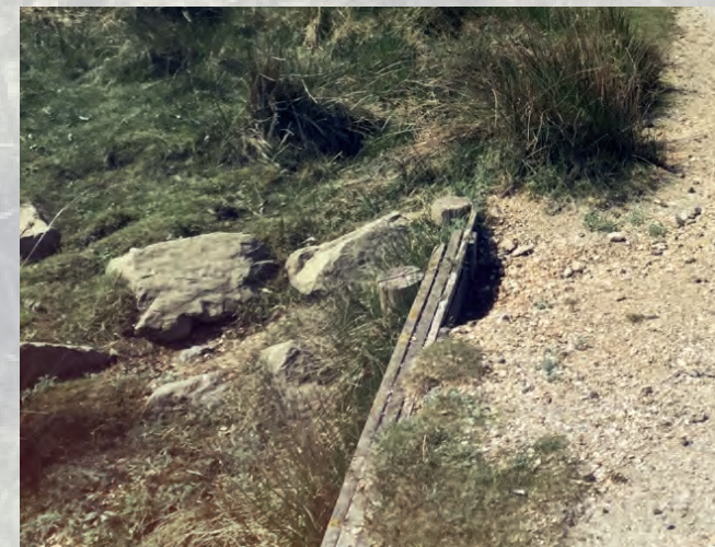
Afbeelding 20 Voorbeeld uitspoeling naast harde constructie
