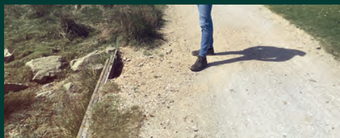
Afbeelding 7 Uitspoeling bij de beschoeiing van de duiker
