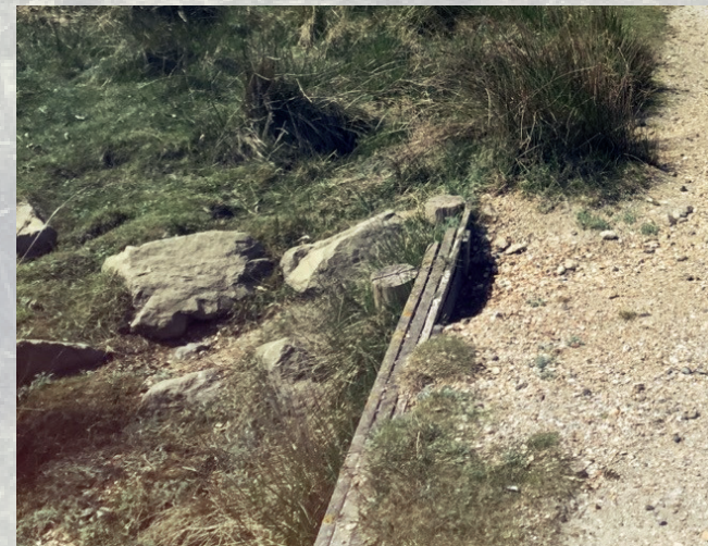
Afbeelding 20 Voorbeeld uitspoeling naast harde constructie
