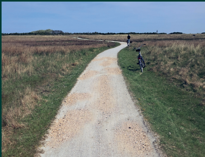
Afbeelding 12 Aanvulling van kuilen die ontstaan zijn door wateroverlast op het Kwelderpad
