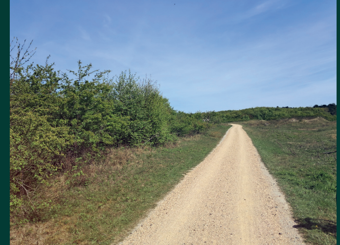
Afbeelding 8 Kleischelpenpad overlaagd met schelpen met leem
