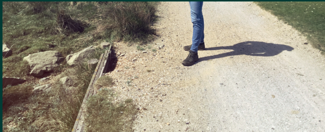
Afbeelding 7 Uitspoeling bij de beschoeiing van de duiker
