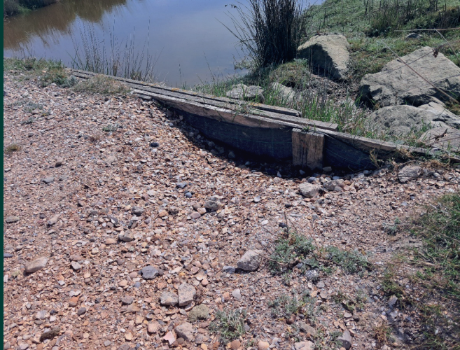
Afbeelding 6 Kuil bij de beschoeiing van de duiker
