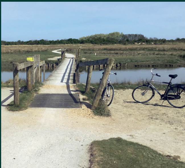
Afbeelding 5 Brug met herstelde uitspoeling
