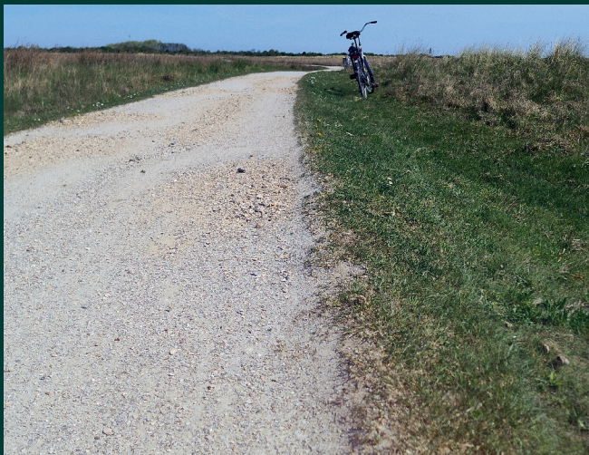
Afbeelding 4 Oplopende randen en kleurverschil in aanvulling
