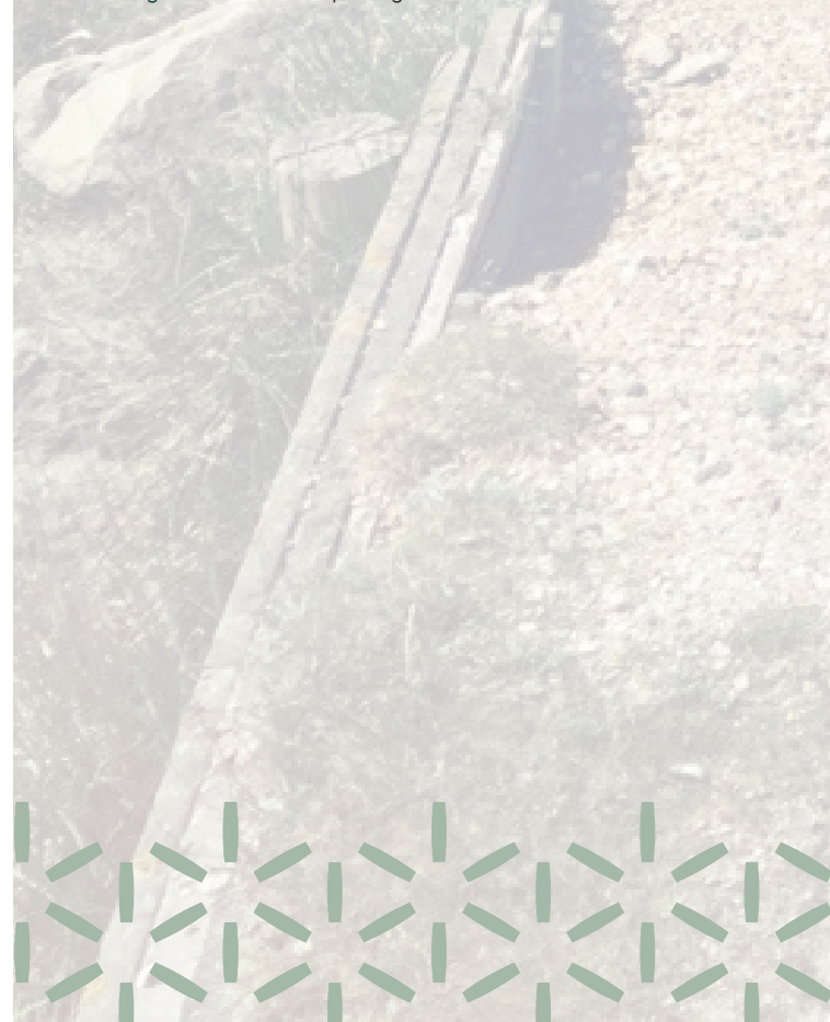
Afbeelding 20 Voorbeeld uitspoeling naast harde constructie
