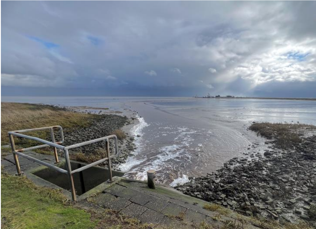
Afbeelding 7. Het zoetwateroverschot in de polder wordt oostelijk van de Veerdam via een spuiduiker afgevoerd naar de Waddenzee. Dat gebeurt onder natuurlijk verval bij laagwater op de Waddenzee.
