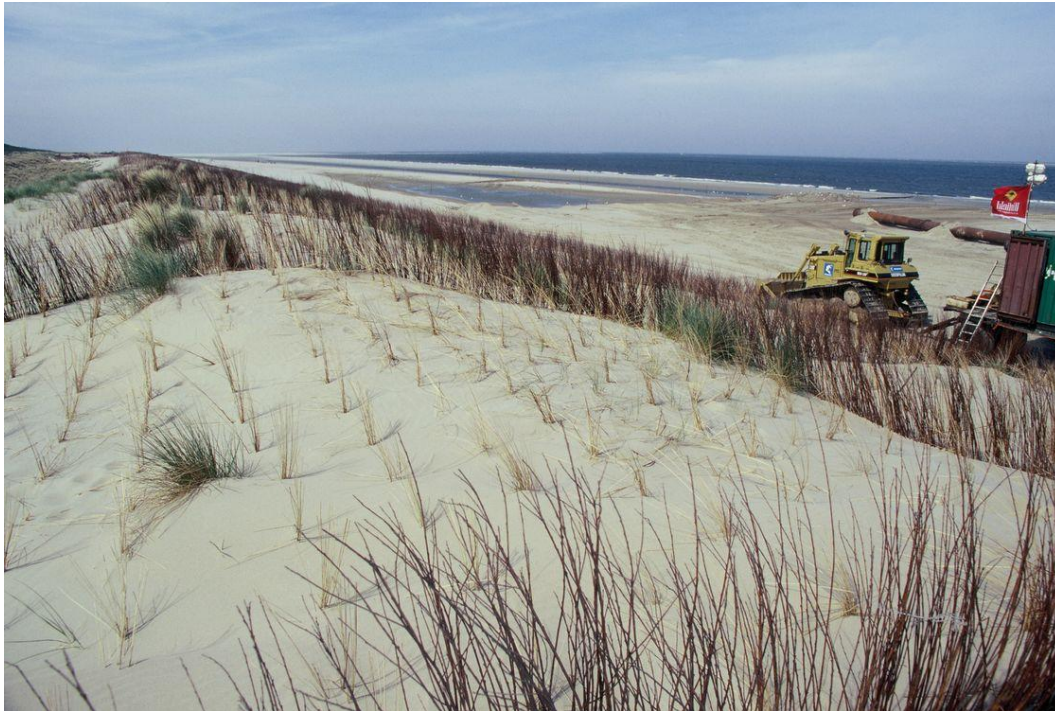
Figuur 10: voorbeeld combi stuifscherm en helmaanplant (Bron: https://beeldbank.rws.nl , Rijkswaterstaat )
